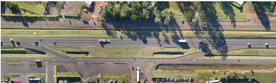
Figura 5 - Acessos da marginal esquerda no KM 588 da BR 277, sentido crescente, em 2021.
