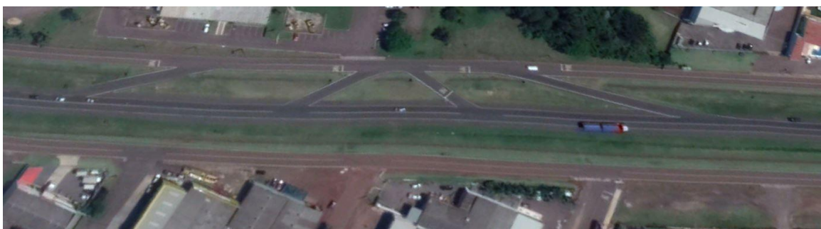
Figura 1- Acessos da marginal direita no KM 588 da BR 277, sentido crescente.
