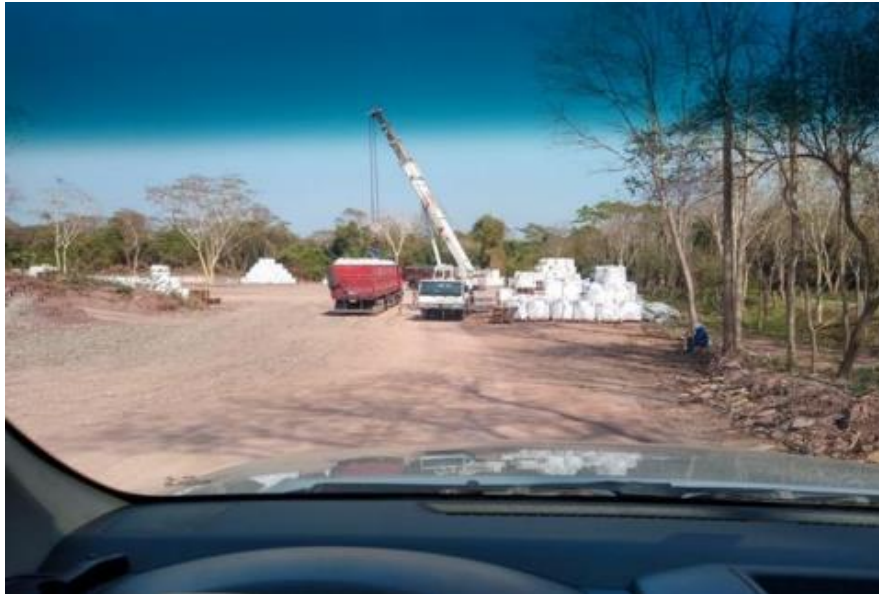
Figura 12 – Área externa 2, movimentação e descarga de borato
