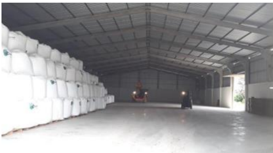
Figura 9 – Galpão 2/interior – ureia e cloreto de potássio
