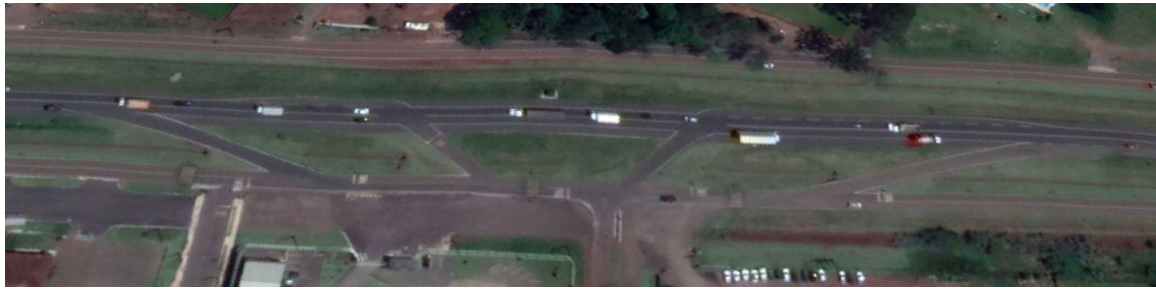
Figura 2 - Acessos da marginal esquerda no KM 588 da BR 277, sentido crescente.
